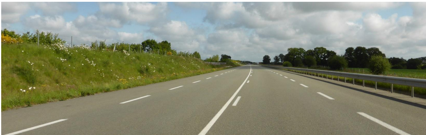
UP01-40-XXX L'axe de contournement de Mayenne est accompagné d'un talus qui limite la covisibilité avec la ville. (Mayenne - 2015)
