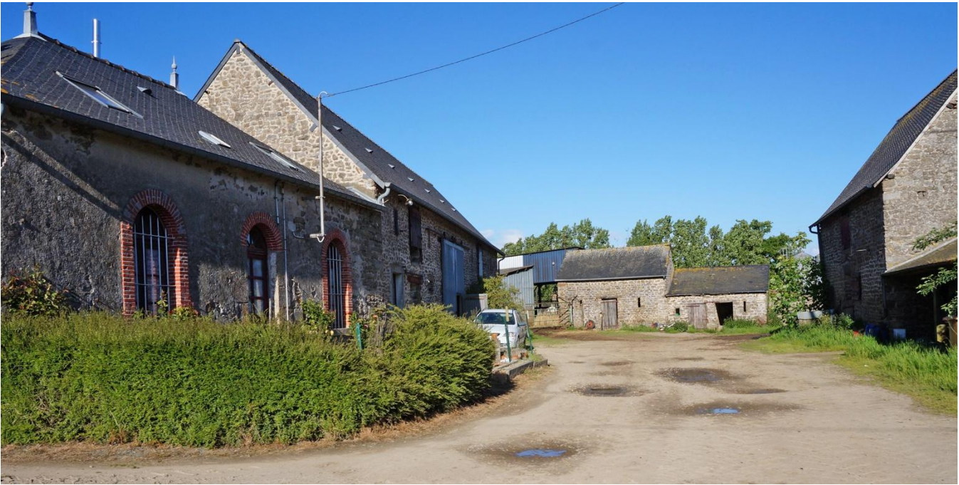
UP2-20-19 Un bâti traditionnel de granit et briques à toit d'ardoise qui s'organise en U autour d'une cour exposée au sud (La Bazoge-Montpinçon)
