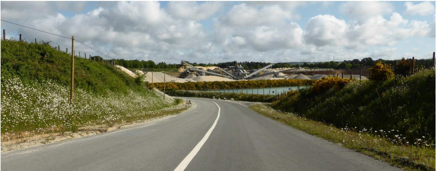
UP01-40-XXX La perception de la carrière de Saint-Fraimbault-de-Prière depuis l'extérieur est assez limitée (Saint-Fraimbault-de-Prière – 2015)
