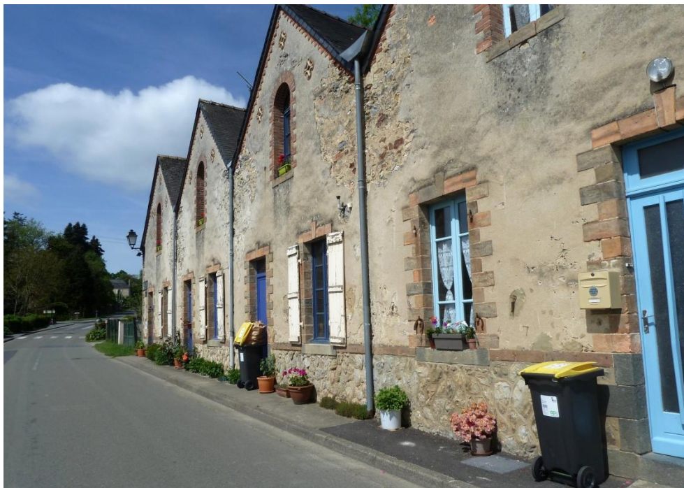
UP00-c Maison ouvrière (Parné-sur-Roc)
