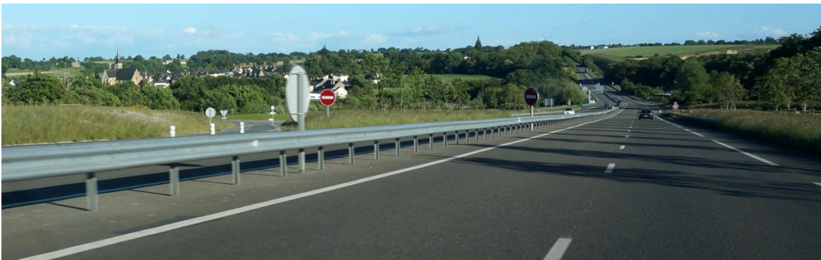
UP2-32-03 Des infrastructures marquantes qui induisent une pression urbaine sur les bourgs (Louvigné)
