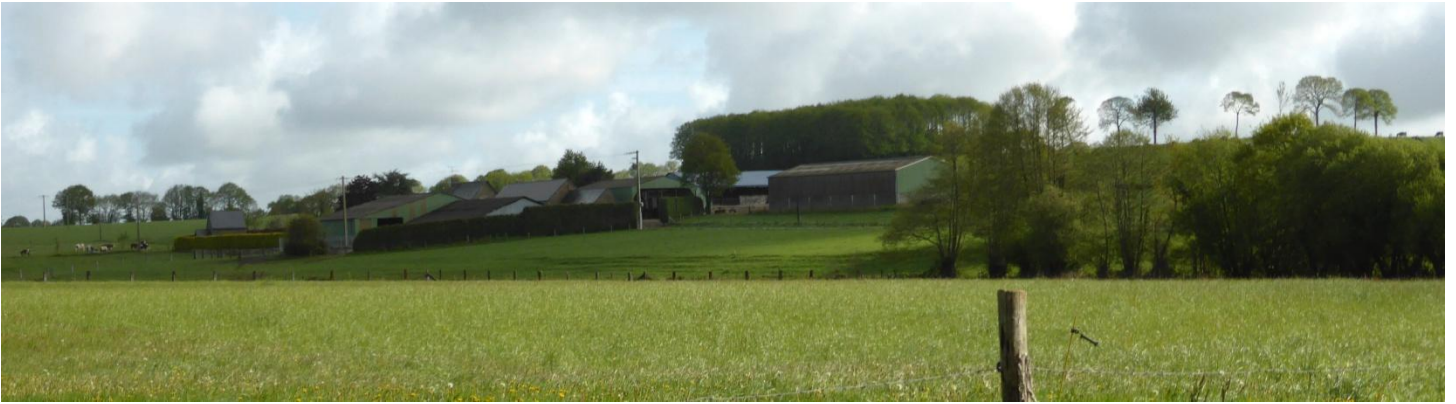
UP01-50- XXX La prise en compte de la pente pour l'installation de bâti agricole favorise l'intégration paysagère (Hercé)
