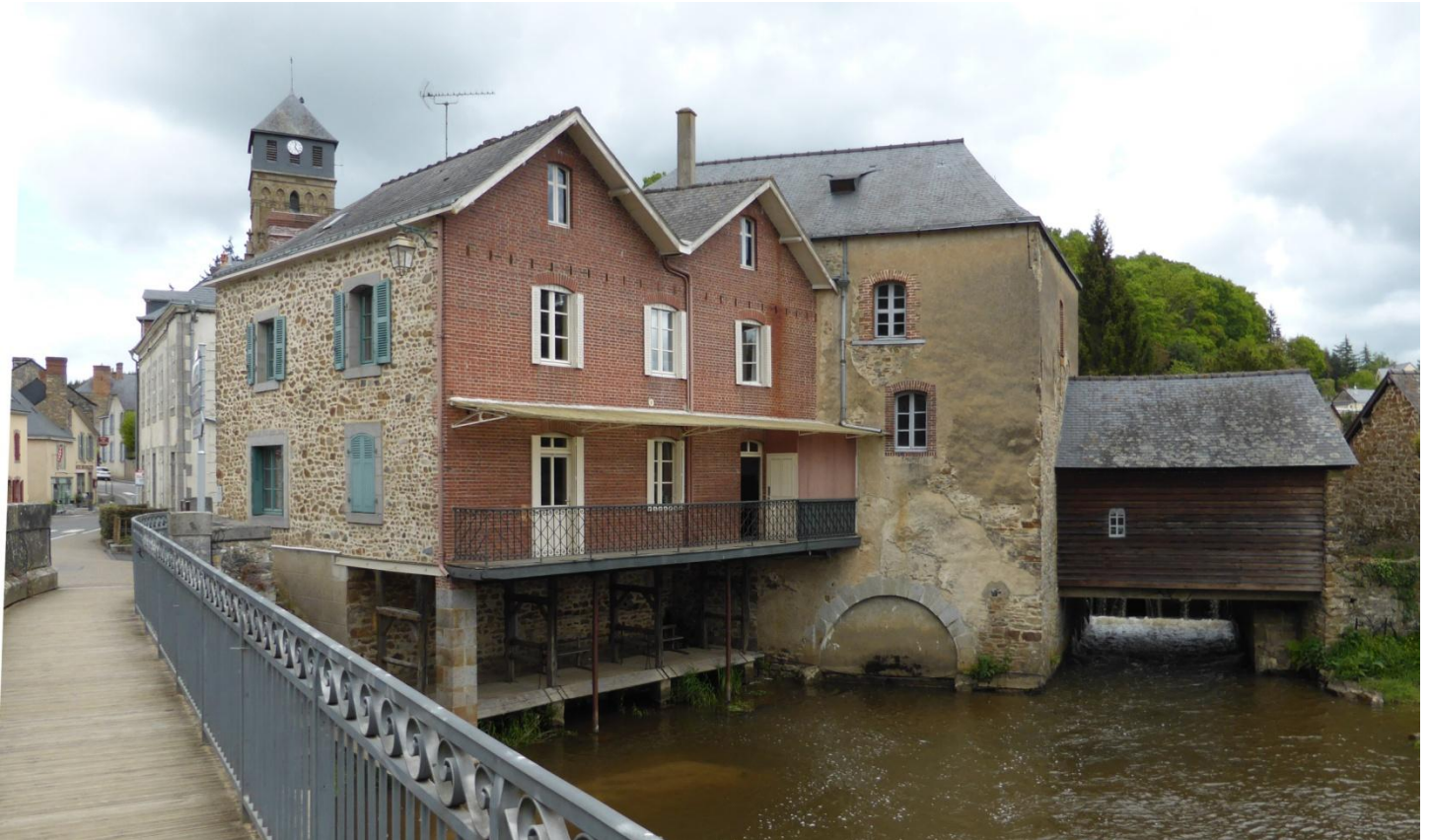
UP01-50- XXX La réhabilitation du patrimoine ancien liée à l'eau participe à la valorisation des centres historiques (Chailland)
