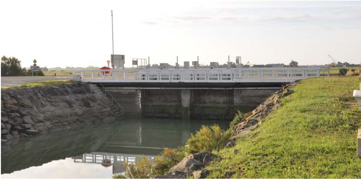
IM15101030-18 écluse : Les écluses, des ouvrages de régulation de l'eau majeurs dans les paysages de marais
