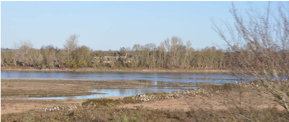
IM15101030-19 épi: les épis ligériens, des empierrements visant à conserver un chenal de navigation
