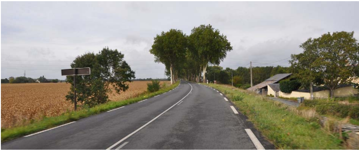
IM15101030-16 levée : La levée de l'Authion protège les terres agricoles céréalières des crues de la Loire et de l'Authion
