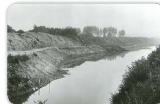
Travaux de recalibrage de l'Authion dans les années 1970
