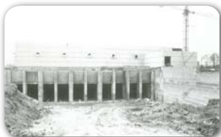
Construction de la station d'exhaure des Ponts-de-Cé
