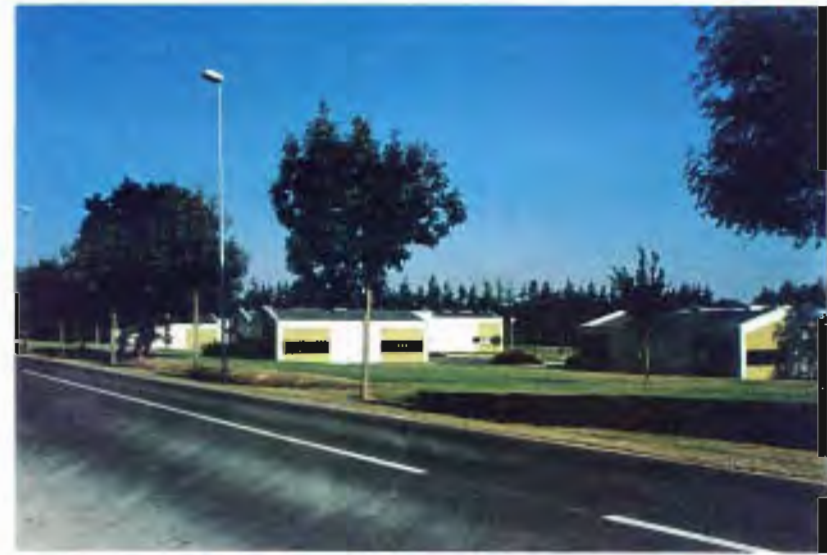
Zone d'activités, route de Craon : des bâtiments de taille réduite, des formes adaptées, des couleurs qui s'intègrent relativement dans le cadre (vert foncé) qui contrastent avec quelques bâtiments clairs.
