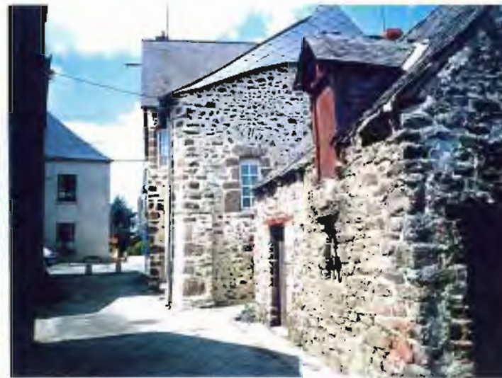
Le Ribay : densité, chaleur des matériaux, une ambiance des centres anciens à préserver
