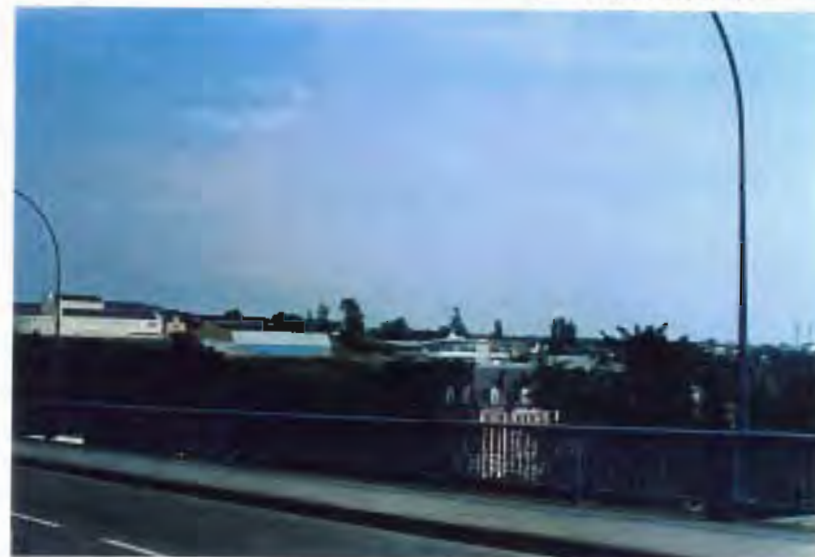
Equipements au sommet du coteau dominant la Mayenne
