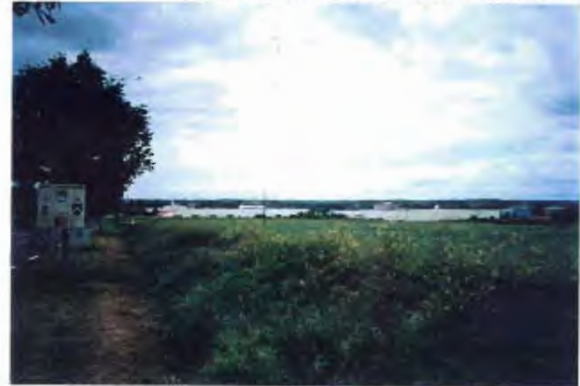
Zone d'activités, route de Sablé : des bâtiments aux formes horizontales permettant une bonne intégration dans les lignes directrices du paysage. Par contre, les coloris clairs ne permettant pas à la structure de se fondre dans l'environnement.
