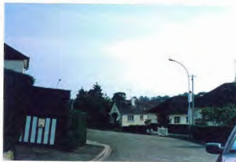
Lotissement des années 1970 : un type d'habitat banalisé à travers toute la France, qui ne tient pas compte des caractéristiques locales (formes, pente de toit, alignement, continuité de bâti, matériaux, couleurs...). Des conceptions transposables dans les programmes d'urbanisation futurs, et compatibles avec l'habitat individuel.
