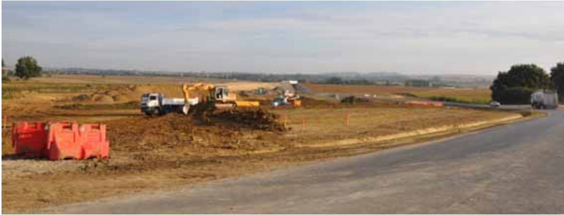
Chantier LGV Sarthe
