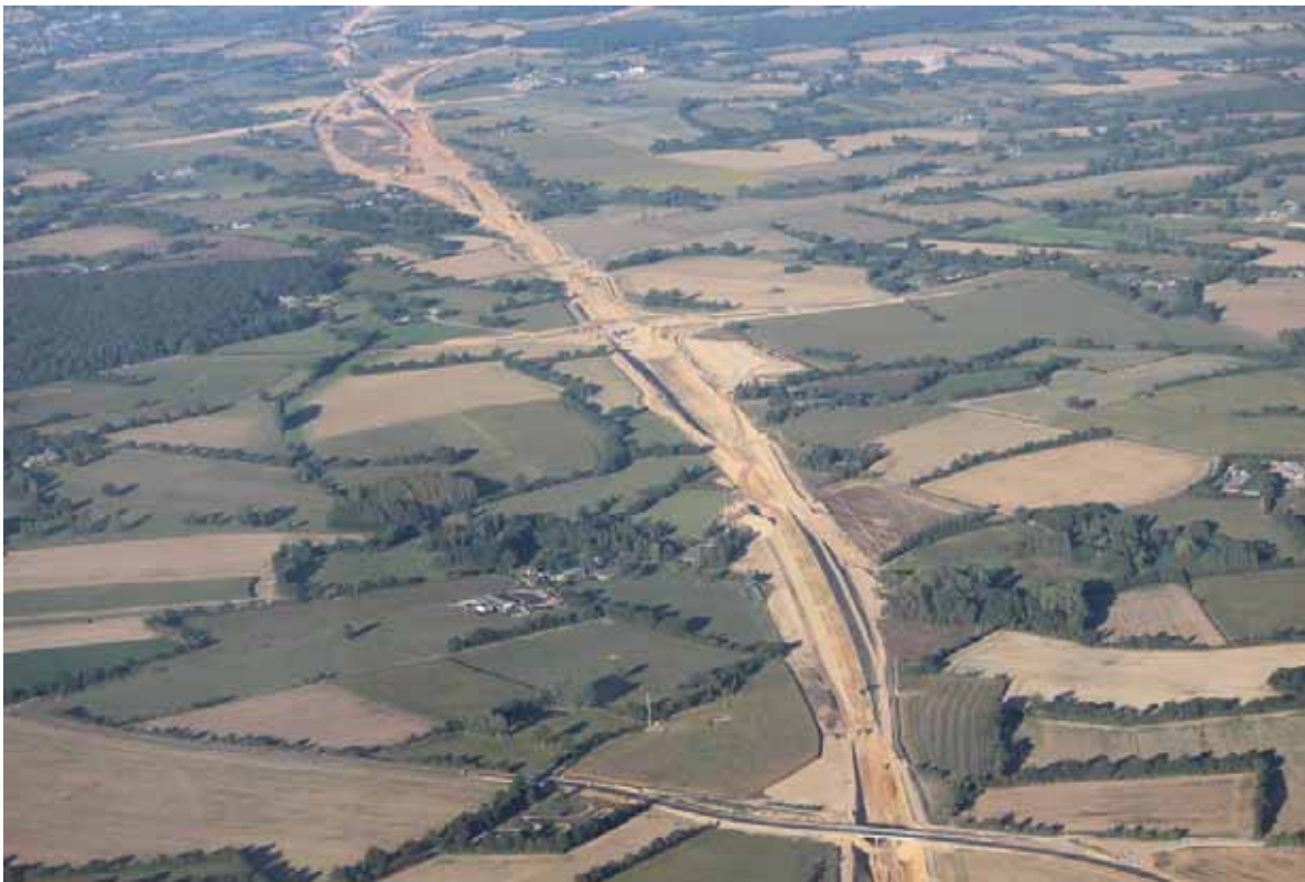
Chantier LGV Loiron (ouest de Laval)
