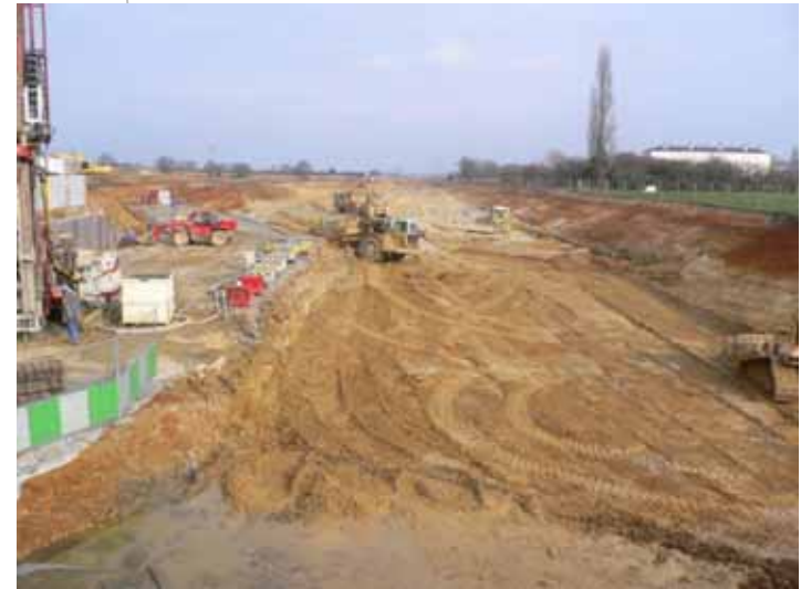
Travaux lors du contournement Nord d'Angers.
