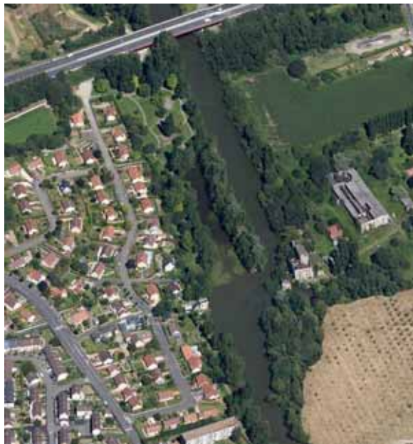
Vallée de la Sarthe –périphérie nord du Mans
