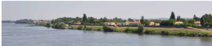
Hameaux développés sur les levées
