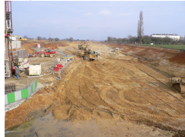
Travaux lors du contournement Nord d'Angers.
